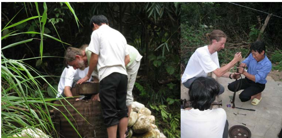
Images 14 et 15 : Réparation de la turbine et de son axe
